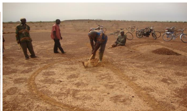
une demi-lune en construction
