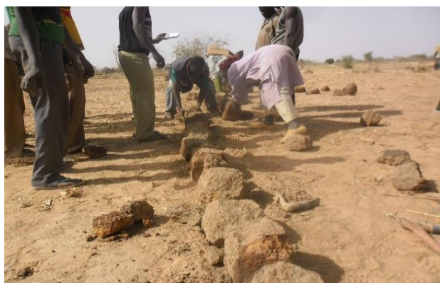
la mise en place des diguettes
