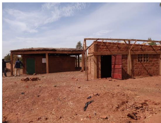
1 ère cave terminée et la 2 e en voie d'achèvement
