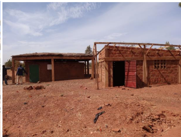
1. Keller ist fertig, der 2. kurz vor der Fertigstellung
