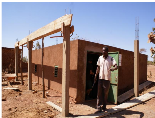
Dachanhebung des 1. Keller
