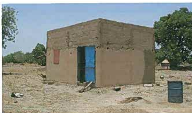
La cuisine-réfectoire en phase terminale
