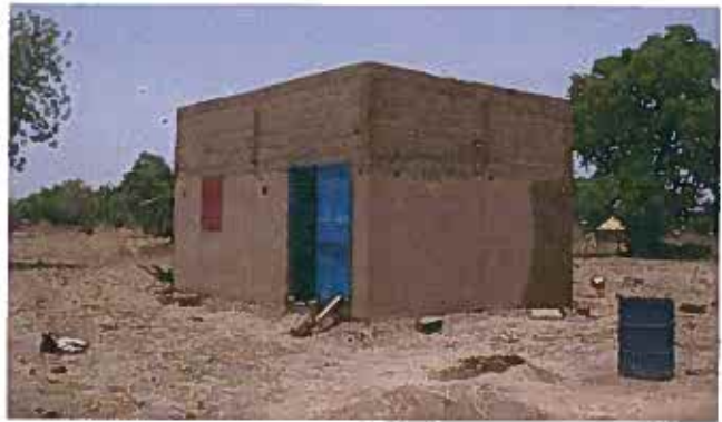
Die Küche in der Endbauphase :
